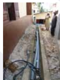
Pose des canalisations d'eau
