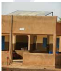
Les panneaux solaires sur le toit du Hall de Récréation
