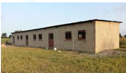
Bâtiment construit par les villageois
