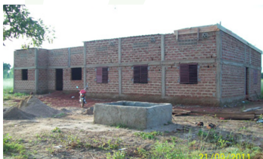
Construction du CREN
