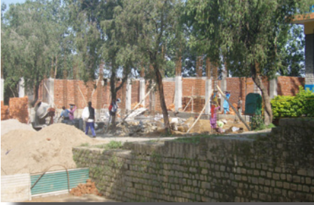
Construction du dortoir
