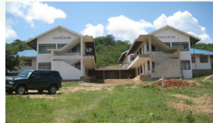
Le nouveau lycée
